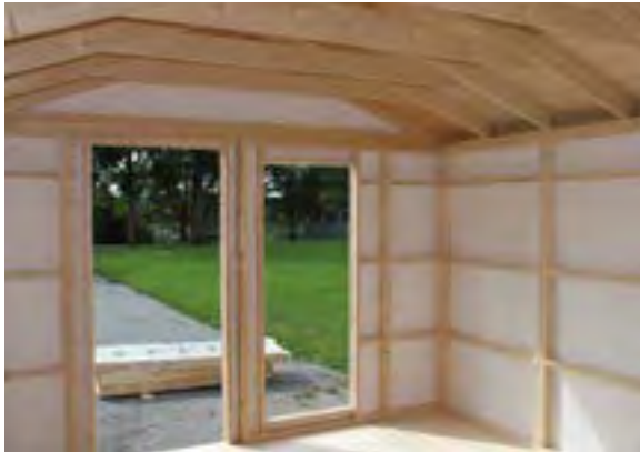
Innenansicht, Wände mit Windschutzfolie
